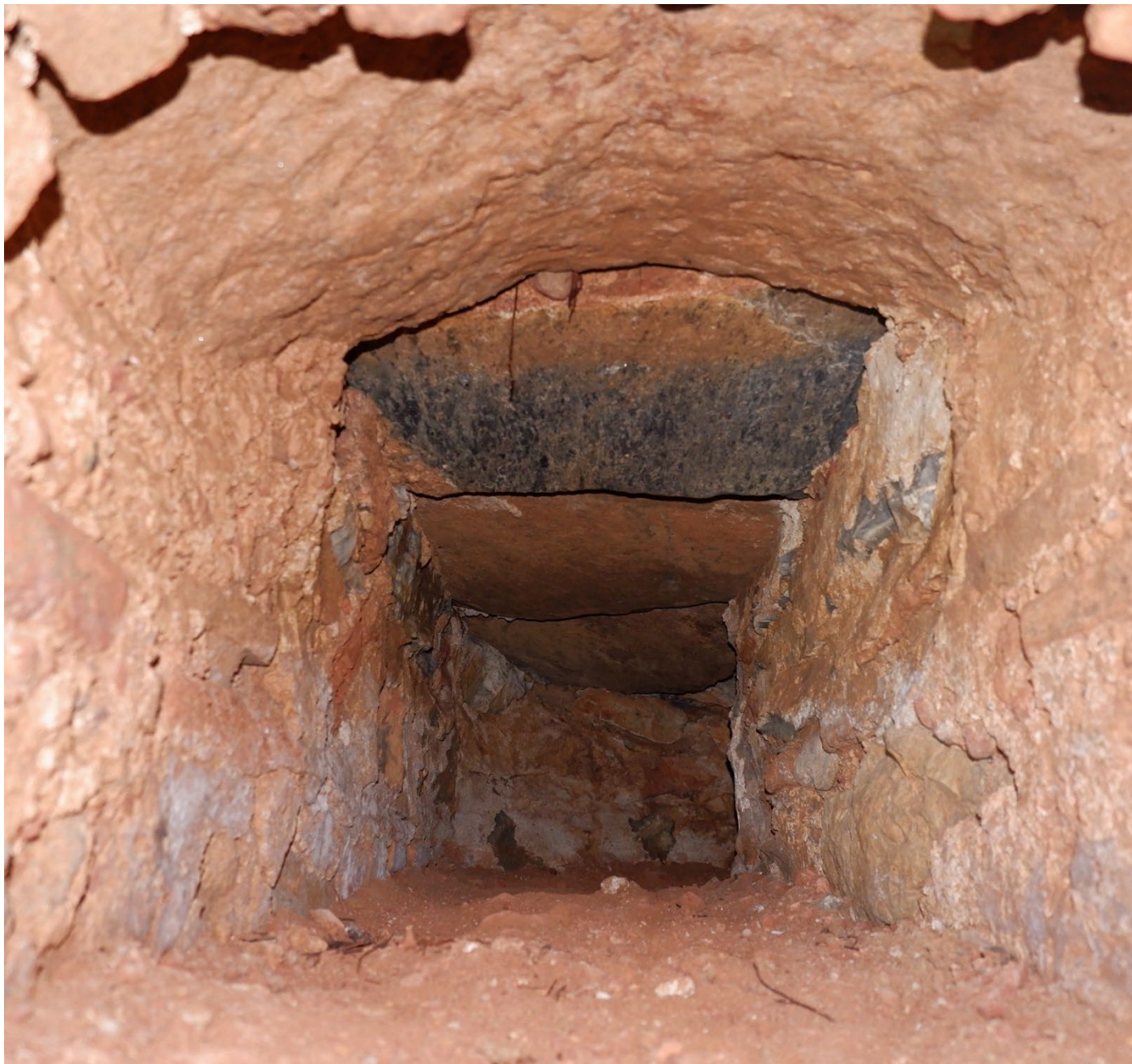
Εικ. 47 Είσοδος κανάλιού Χαλανδρίου λίθινο τόξο στο πάχος του εξωτερικού τοίχου
