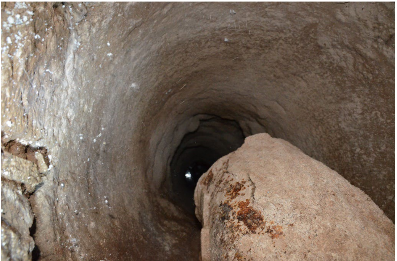
Εικ. 44 Σημείο σύνδεσης με κατακόρυφο φρεάτιο (102) άποψη προς τα κάτω. Στο βάθος φαίνεται αντανάκλαση νερού από το υδραγωγείο. Η περιοχή είναι καλυμμένη με κονίαμα λόγω της ύπαρξης νερού. Επίσης βλέπουμε μεταλλική «γωνιά» σωλήνας ύδρευσης σε πρώτο πλάνο. Πιθανών για να κατευθύνει την ροή του νερού και να μην γλύφει τα τοιχώματα.
