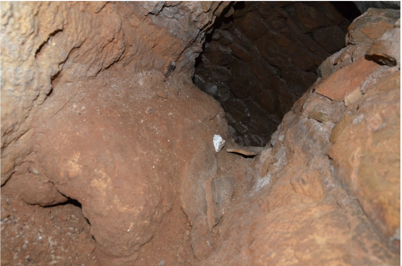
Εικ. 43 Σημείο σύνδεσης με κατακόρυφο φρεάτιο (102) άποψη λίθινης κατασκευής που συγκρατεί την μεταλλική γωνιά και υποχρεώνει να περάσει το νερό από μέσα..
