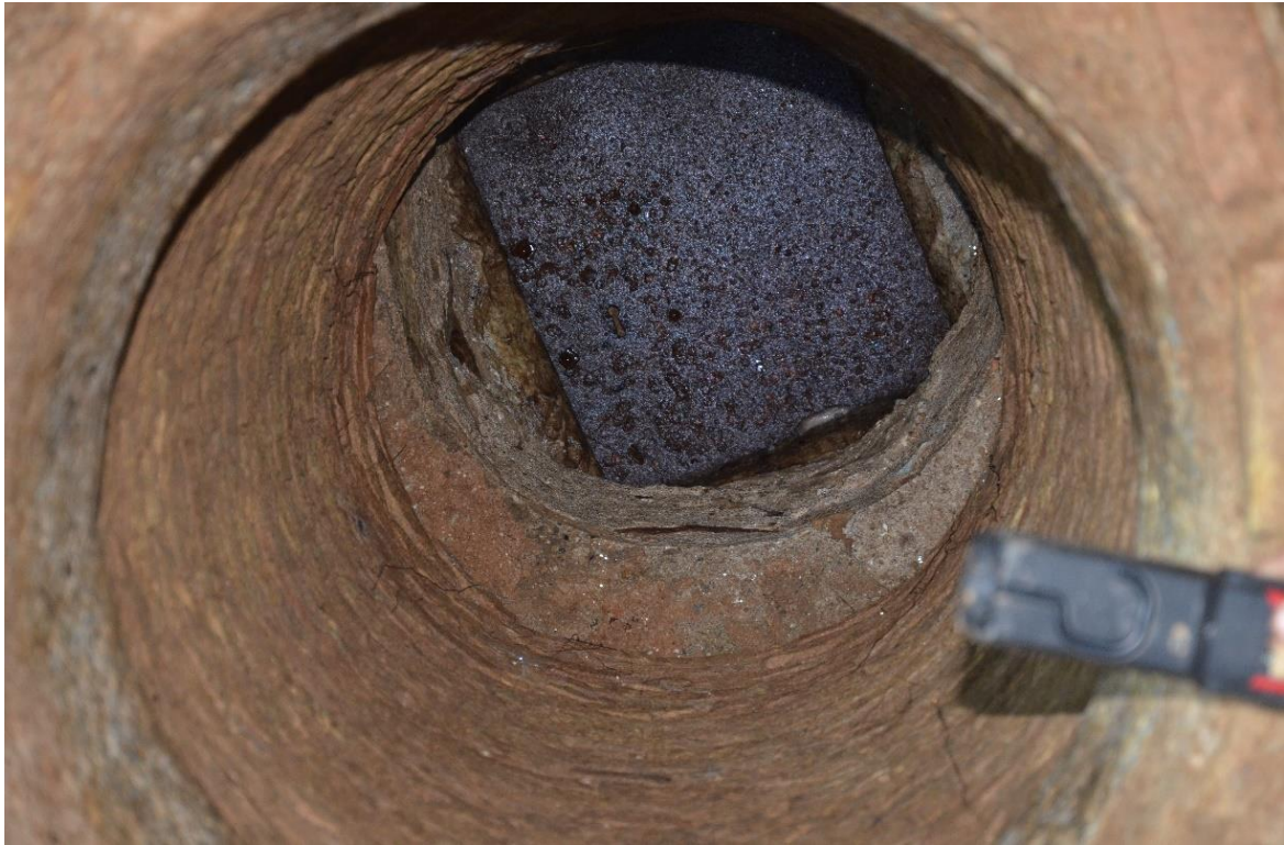
Εικ. 19 Φανός στην κορυφή του θολωτού χώρου, άποψη από το εσωτερικό της δεξαμενής
