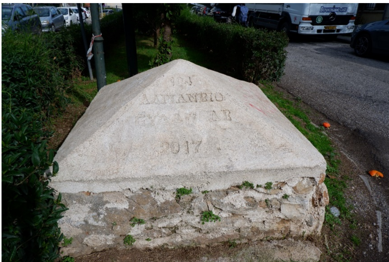
Εικ. 6. Φρεατοσκέπασμα φρεάτιου 104
