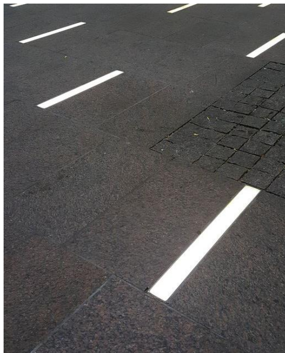
Εικ. 55: Εικόνα αναφοράς για επιδαπέδια γραμμικά φωτιστικά
