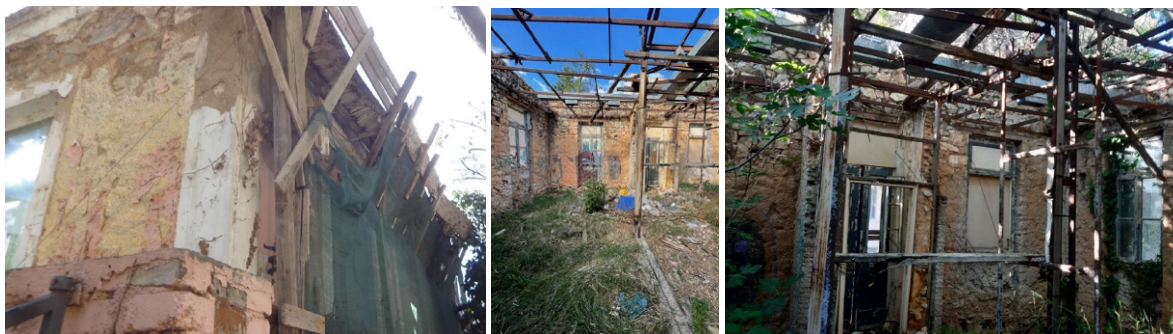
Εικόνα 3: απόψεις υφιστάμενου κτιρίου
