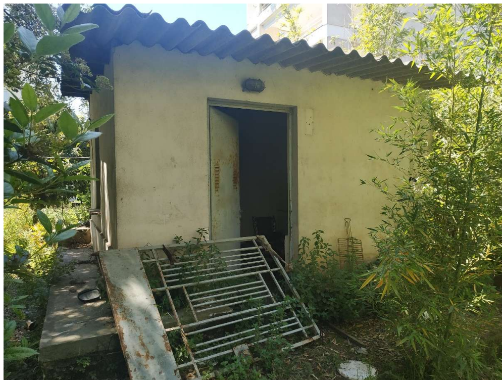
Εικόνα 1 Η επικάλυψη του κτιρίου Κ3 με κυματοειδή φύλλα αμιαντοσιμέντου
