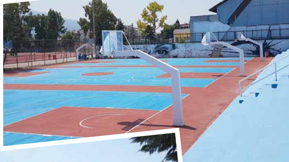
Αναβάθμιση του κλειστού κολυμβητηρίου και των ανοιχτών γηπέδων στο συγκρότημα «Νίκος Πέρκιζας».
